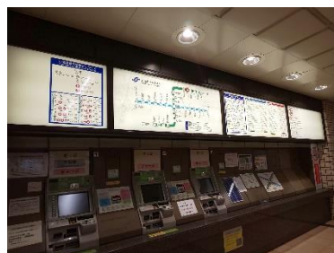
南北線駅舎 LED 化
