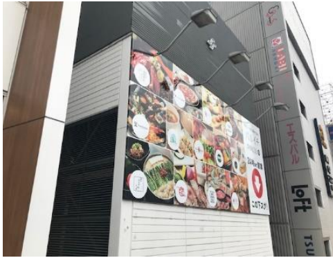
仙台駅換気塔
